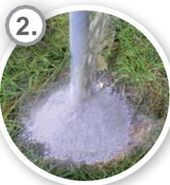
**2.** Centrer l'objet à fixer dans le trou et verser le produit jusqu'à environ 1/4 de la profondeur du trou, ajouter de l'eau avec un arrosoir muni d'une pomme de douche jusqu'à saturation, verser le reste du produit et le répartir uniformément dans le trou.
